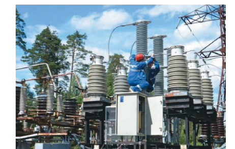
▶ Шефмонтаж вакуумного выключателя ВРС-110
