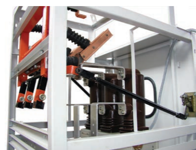
▶ Реконструкция КСО при помощи универсального монтажного комплекта
