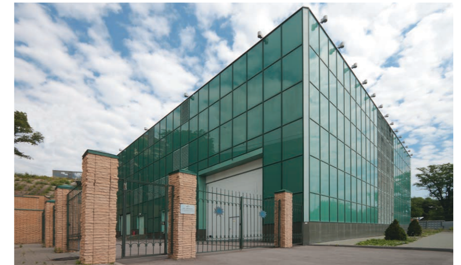
Подстанция 110/35/10 кВ Р-22 «Ростовэнерго»
