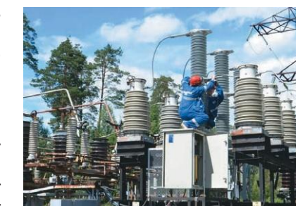
▶ Шефмонтаж вакуумного выключателя ВРС-110
