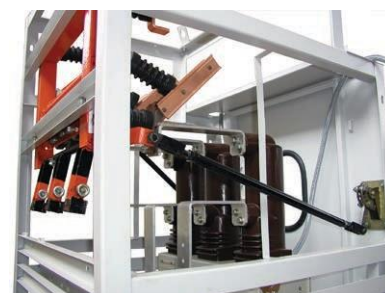
▶ Реконструкция КСО при помощи универсального монтажного комплекта
