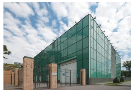
▶ Подстанция 110/35/10 кВ Р-22, Ф-л ОАО «МРСК Юга» – «Ростовэнерго», Россия
